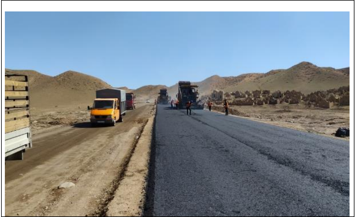
Рисунок 4 Работы на строительном участке
