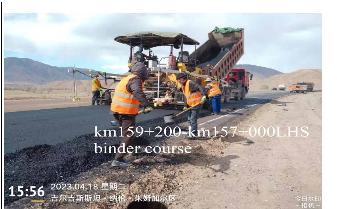
Рисунок 15 Строительные работы на проектной дороге
